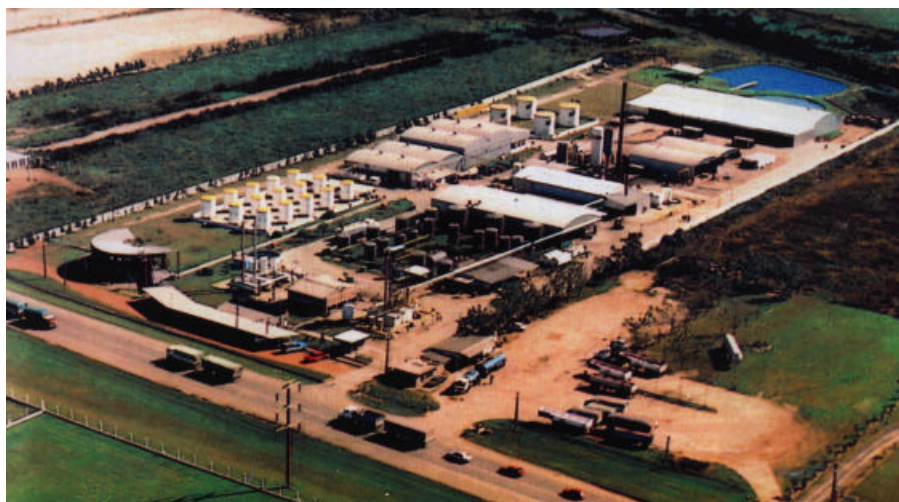
Foto 1. Vista aérea de la planta de tratamiento IDM
